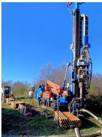
Dans un souci de respect de l'environnement, le choix s'est porté sur la géothermie pour le futur EHPAD. Cette solution écologique permet de capter la chaleur naturellement présente sous la surface de la terre afin de chauffer le bâtiment et de le rafraîchir. En moyenne, la température augmente de 3°C tous les 100 mètres de profondeur : plus on descend, plus la chaleur est importante.
